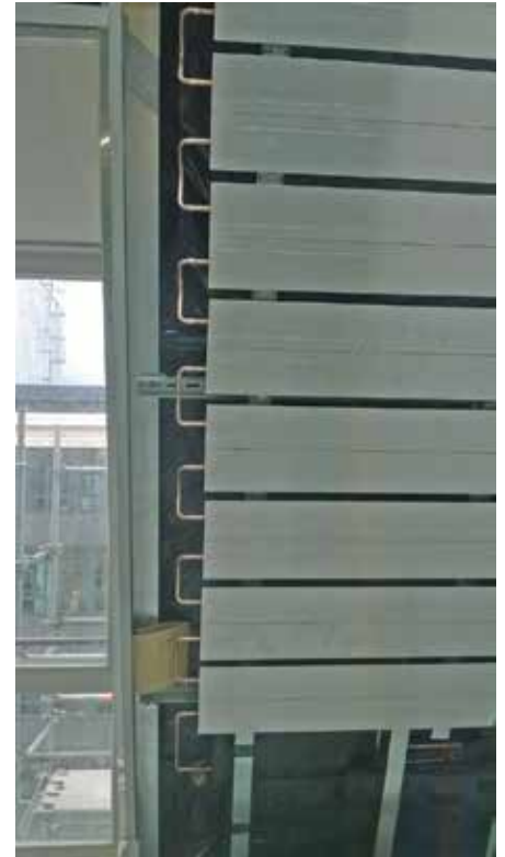
Die Kühldecken bestehen aus einer Trägerplatte und einem vormontierten Rohr. Die Systemplatten können in unterschiedlicher Länge vom Werk aus geliefert werden und zusätzlich auf der Baustelle gekürzt werden.
