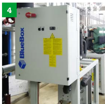
Montage der neuen Kältemaschine
