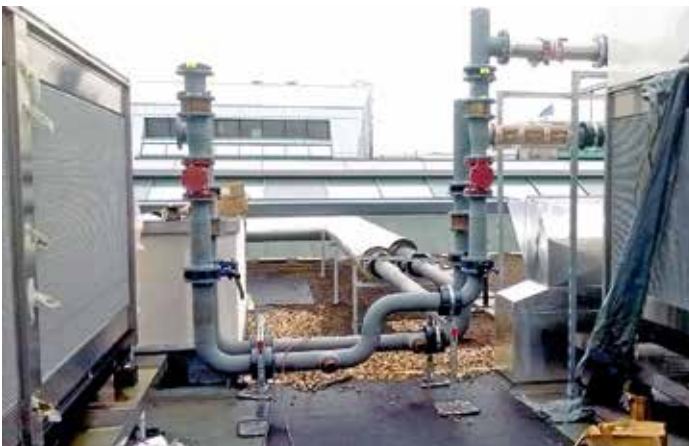
Auf der Dachfläche des Neubaus sind auf 80 m 2 Fläche u. a. zwei Großkälteanlagen und ein Freikühler untergebracht.
