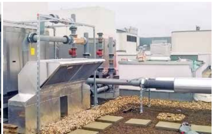
Auf der Dachfläche des Neubaus sind auf 80 m 2 Fläche u. a. zwei Großkälteanlagen und ein Freikühler untergebracht.
